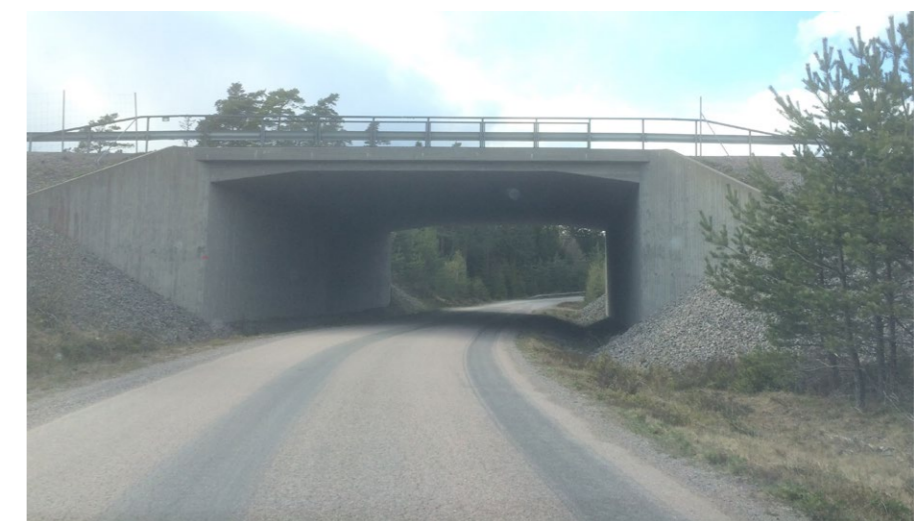
Figur 66. F-1, enskild väg sydost om Gullvagnen som också är passage för Östgötaleden. Befintlig passage under E4. Ostlänken kommer att korsas vägen på bilden en bit bortanför bron.
